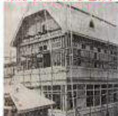
黒沢尻病院建設
